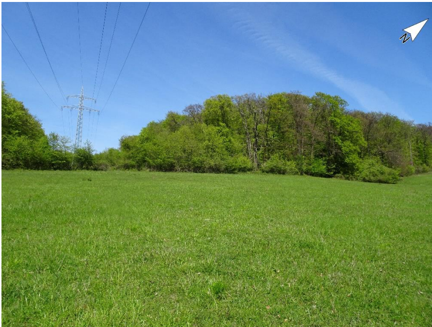
Abb. 24 Darstellung des Schutzstreifen der Bestandsleitung 0159 des Querungsbereiches TKS 09a; Aufnahme vom 03.05.2023.
