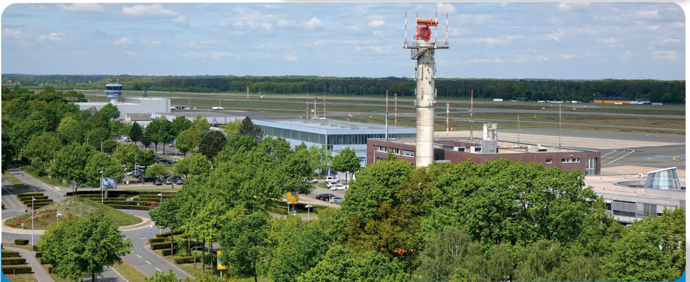
Afb. 2: Luchthaven / Flughafen Münster/Osnabrück
