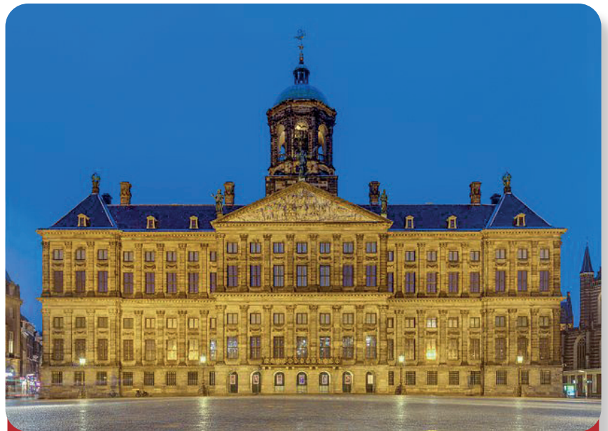
Afb. 3: Koninklijk Paleis Amsterdam, gebouwd uit Bentheimer zandsteen
